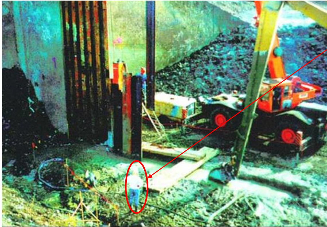
Figur 9 Lövön , foto från schaktning av slurry wall och efterföljande montering av stålspons i diket.
